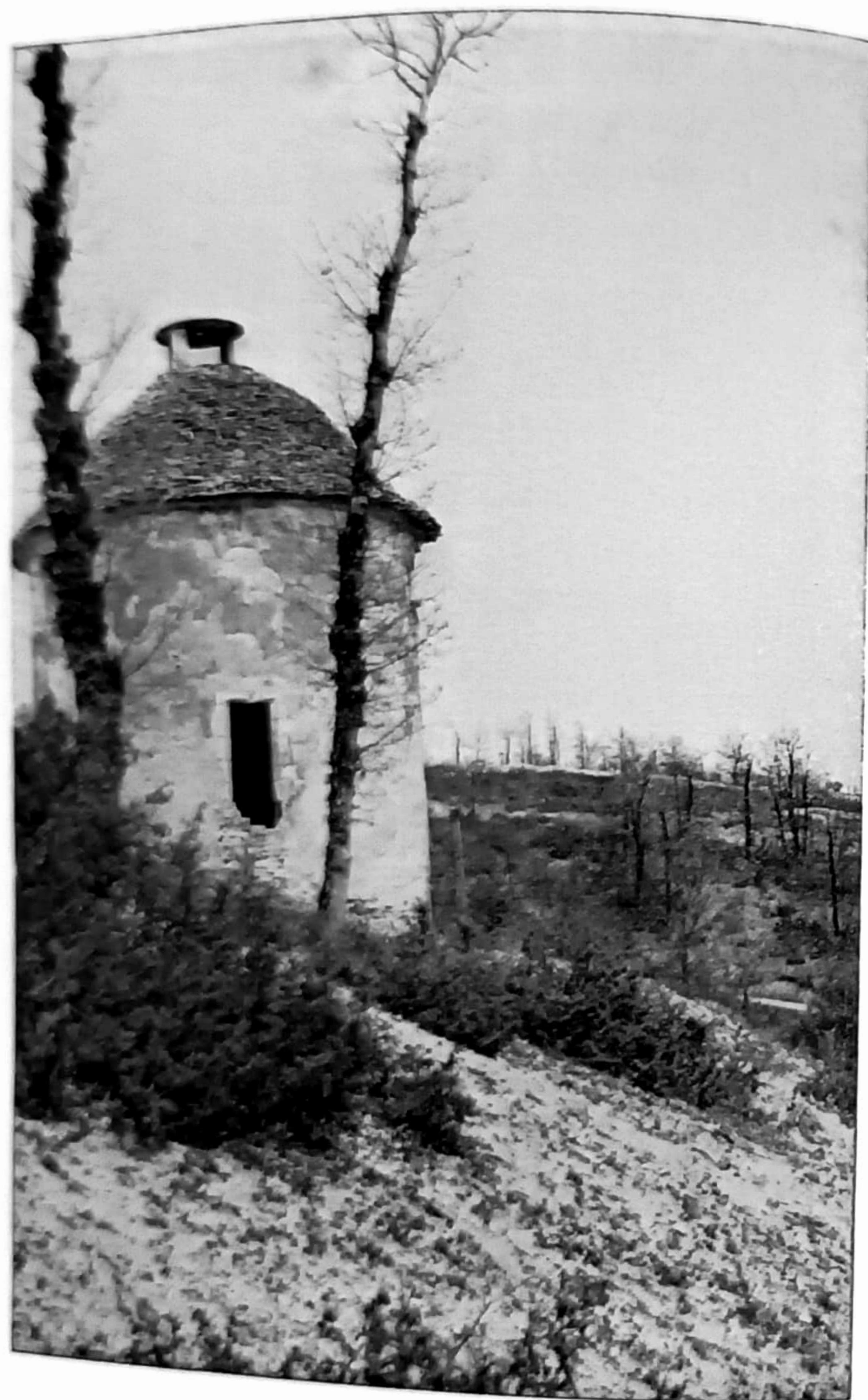
PIGEONNIER CYLINDRIQUE A TOIT DE PIERRE A GIGOUZAC (VOÛTÉ PAR ENCORBELLEMENT)
