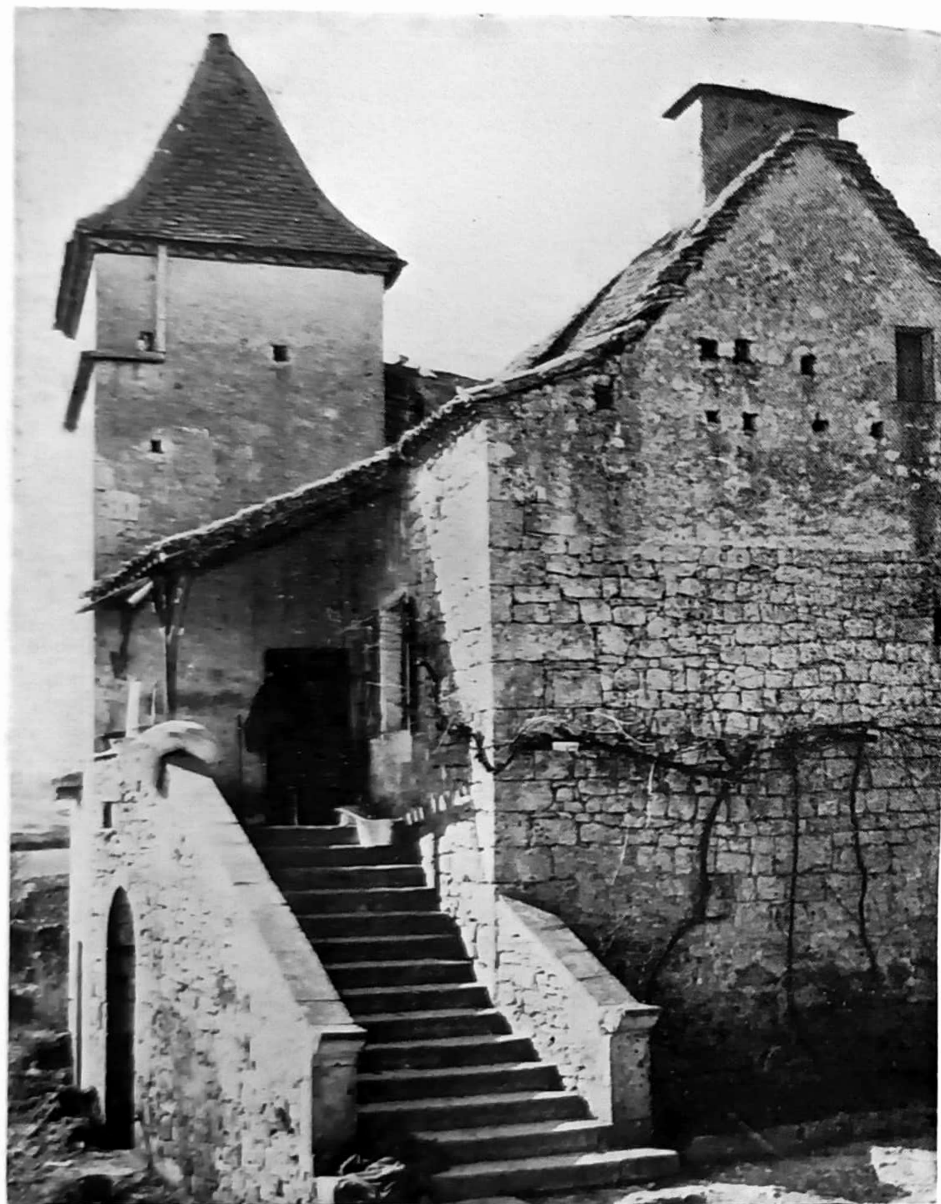
ESCALIER EXTÉRIEUR, BOLET ET PIGEONNIER-TOURELLE A CRAS
