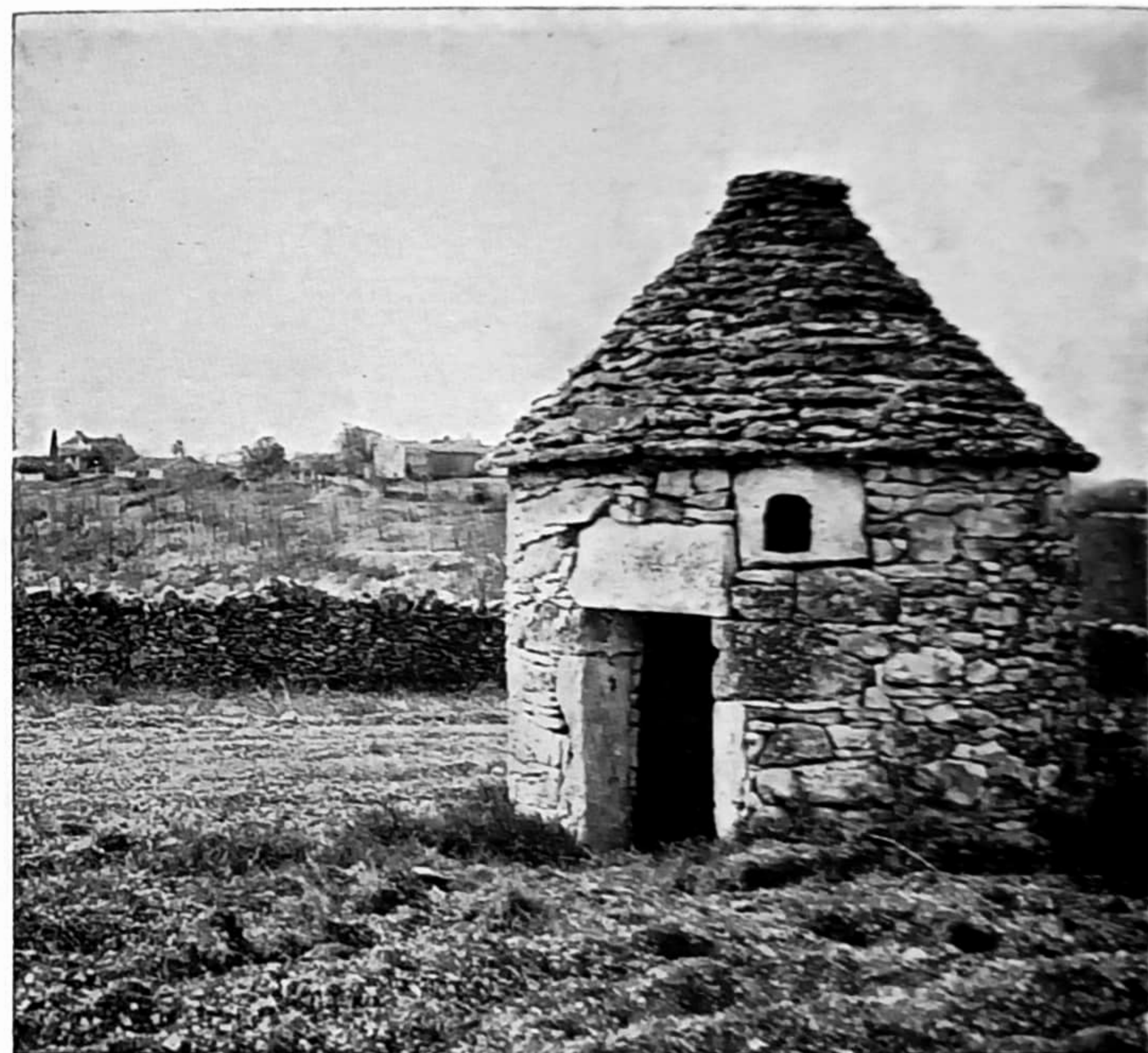
CABANE DE PIERRE A ESCLAUZELS - LINTEAU MONOLITHE
