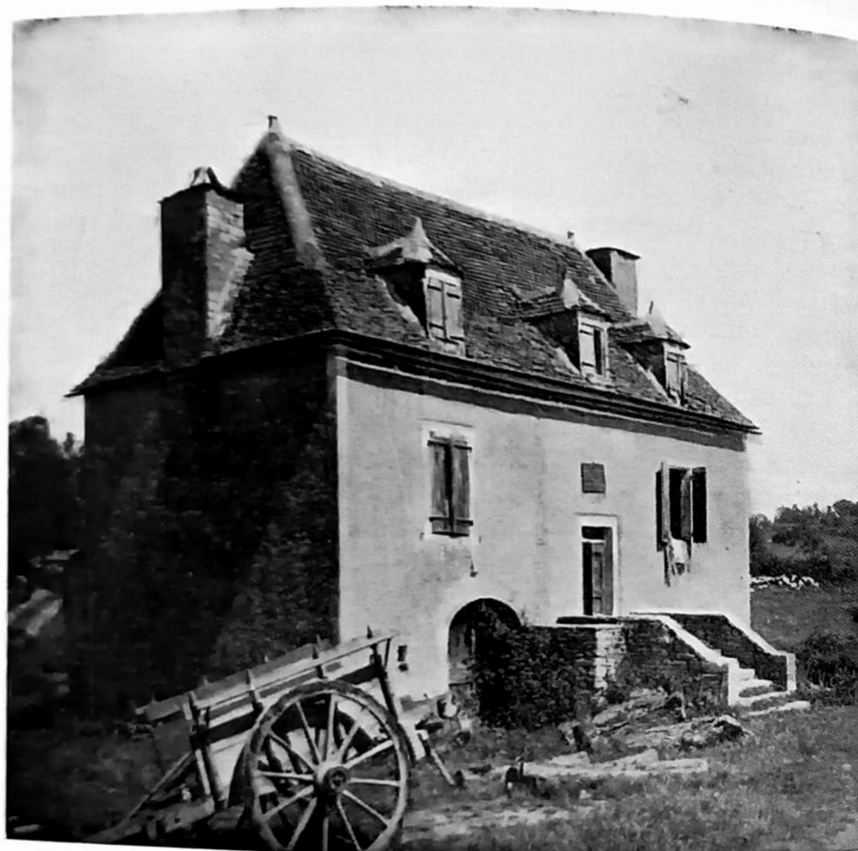
MAISON A SUPERPOSITION DU CAUSSE - TOIT MIXTE : TUILES PLATES ET PIERRES DATÉE DE 1848 - SIFFRAY, COMMUNE DE CATUS
