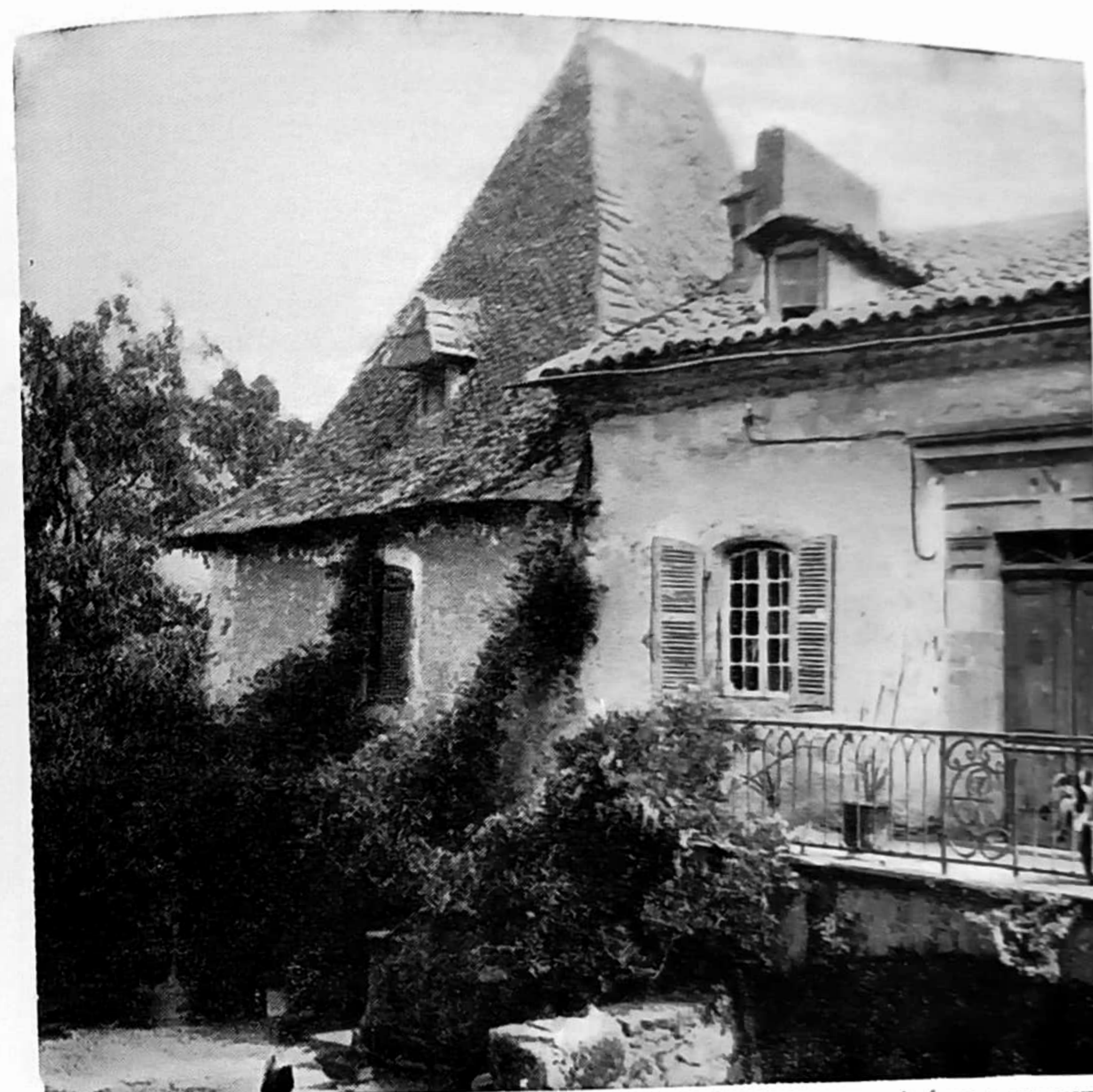
MAISON MIXTE A PORT-D'AGRÈS - TOIT D'ARDOISES DE PAYS DU CÔTÉ DU ROUERQUE TOIT MÉDITERRANÉEN CÔTÉ QUERCY DATÉE DE 1848
